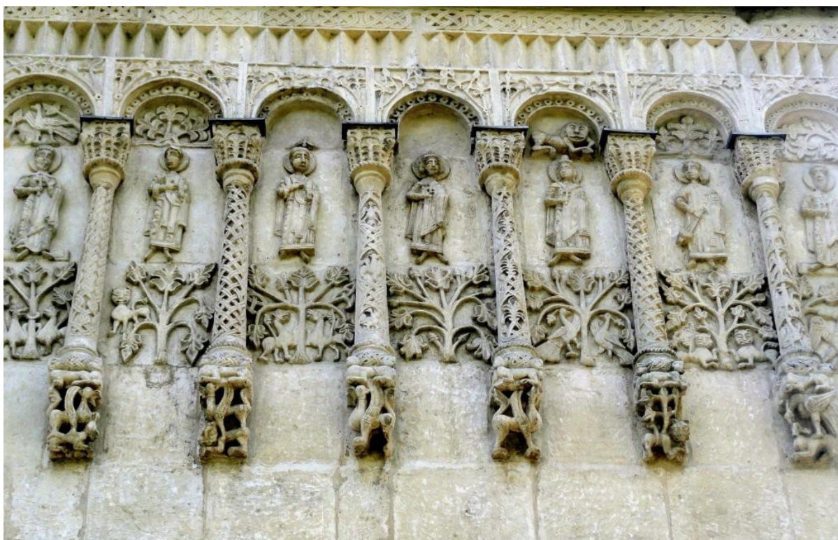
Figure 4. Часть первоначального аркатурно-колончатого пояса в западном прясле северного фасада Дмитриевского собора во Владимире, XII век
