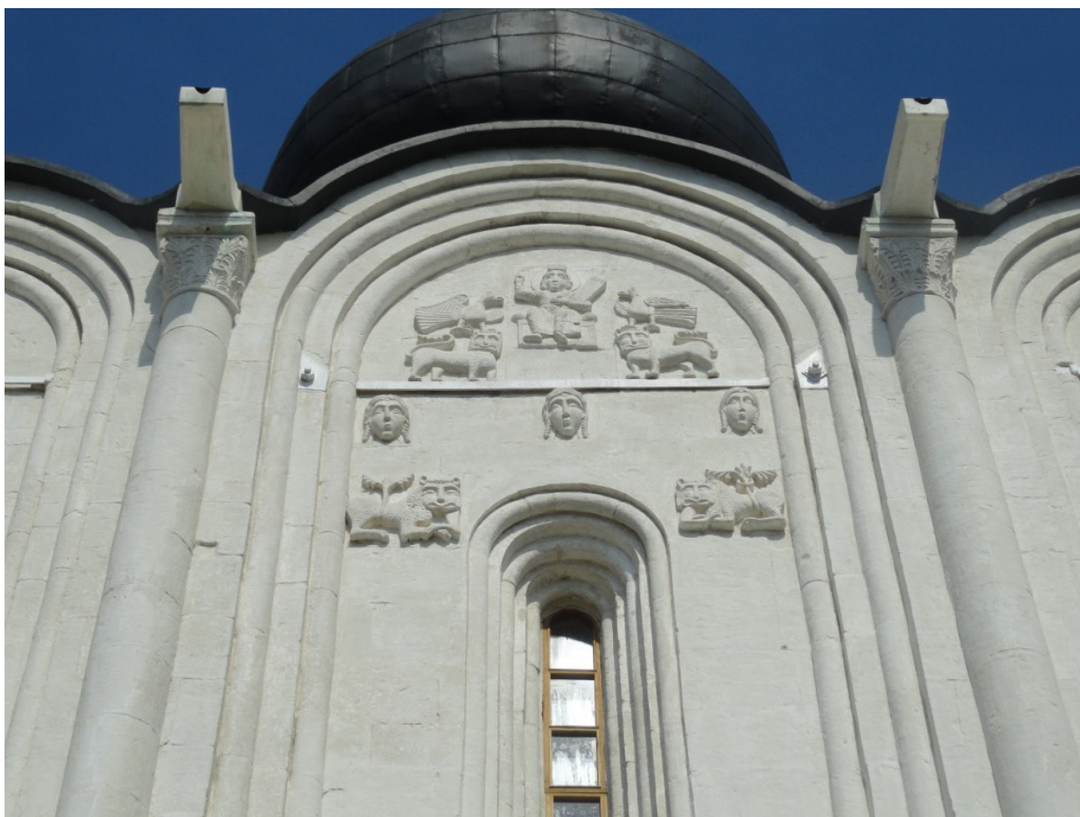
Figure 2. Центральное прясло южного фасада церкви Покрова на Нерли. XII век
