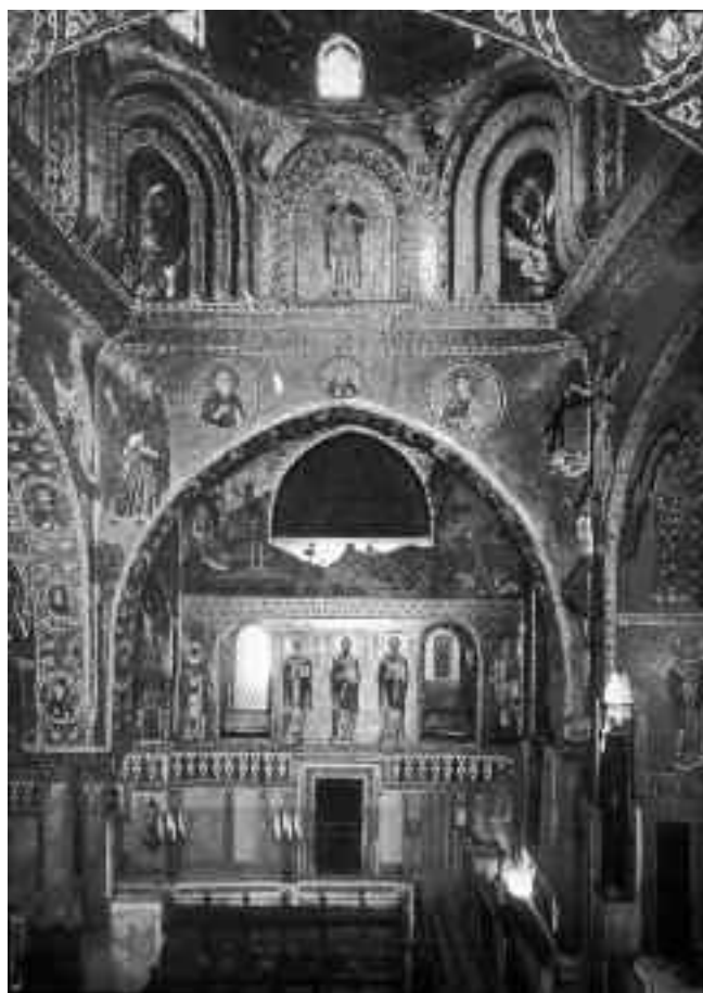
Abb. 5 Cappella Palatina, östlicher Teil, Blick in die Nordkapelle von Süden
