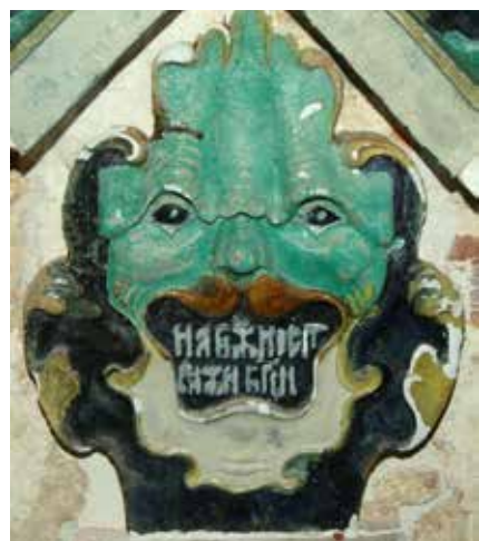
9–10. Фрагменты фронтона алтарного окна на восточном фасаде церкви Всех святых с изображением головки ангела и «поющего» херувима с лицом львиным. В процессе реставрации. Фото начала 2010-х гг.
