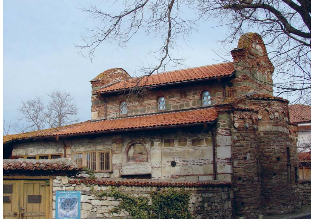
1. Церковь Св. Стефана в Несебре (Новая митрополия). Вид с юго-востока
