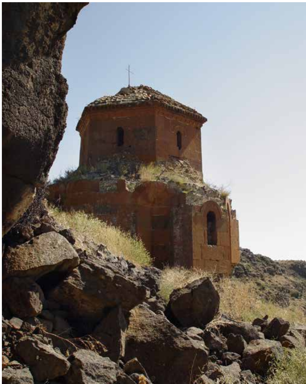
5. Церковь у станции Арагац. Вид с северо-запада. Фото А. Казаряна, 2003
